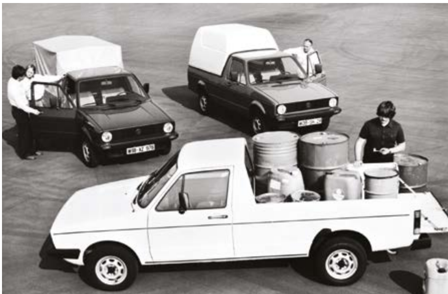
Unificirana TASova ponudba ni vključevala veliko različic. Za izvoz pa so bili na voljo modeli z bencinskim in dizelskim motorjem z močjo 54 do 70 KM, tovorni prostor pa je bil lahko pokrit s cerado ali nadgradnjo iz trde plastike.
