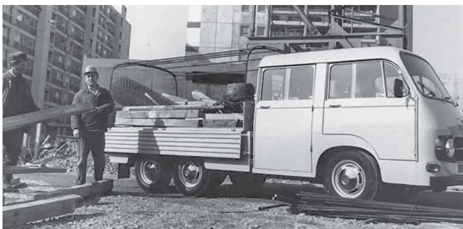
Triosna izvedba se je vrnila leta 1976 kot model 2200 D z Mercedesovim dizelskim motorjem OM 615 (2197 ccm/60 KM). Tovornjaček z dvojno kabino in tovornim delom je dosegal nosilnost 1680 kg in najvišjo hitrost 100 km/h ob povprečni porabi 10 l/100 km.
