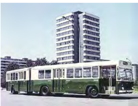
Ikarus G-160 – zglobna izvedba domače konstrukcije s tretjo upravljivo osjo in FAP-ovim motorjem je prav tako ostala v prototipni fazi.
