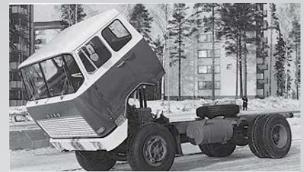
Leta 1962 je model KB – 112 postal prvi evropski tovornjak s serijsko vgrajenim hidravličnim mehanizmom, dvigom trambus kabine.
