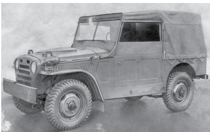
Zastava AR-51 – po razhodu z Willysom so v Kragujevcu za potrebe vojske leta 1954 pričeli s proizvodnjo modernejše izvedbe po Fiatovi licenci. Že naslednje leto so pričeli izdelovati posodobljeno izvedenko AR 55, katere so do leta 1974 izdelali 9089 primerkov v šestih karoserijskih izvedbah
